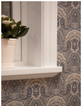
I. TILLVAL Allmoge fönsteromfattning 30 mm MDF obehandlad fönsterbänk som kapas på plats. Foder 15x95 mm allmoge.
