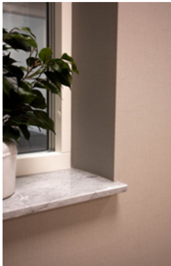
B FÖNSTERBÄNK STANDARD Ingipsad fönstersalning med stenskiva
